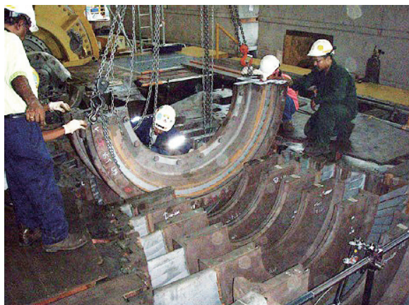
写真5 修正作業風景
