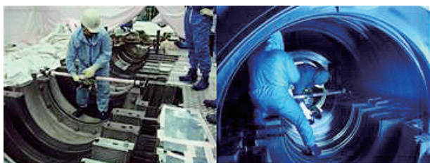
写真6 計測作業風景 (東海第二発電所 左Tops-off, 右Tops-on)
