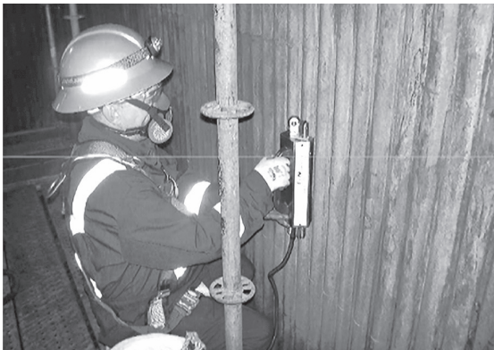
写真3 ボイラー水壁検査
